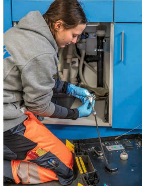
▲ Livia Lüdi montiert einen Bürstenaufsatz, mit dem sie das Rohr anschliessend reinigt.
